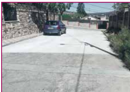
Can Parellada - Reparació del Carrer Bosc
