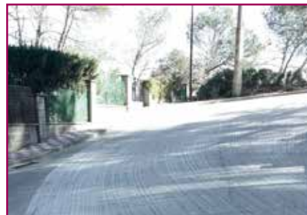
Can Parellada - Tractament antilliscant del paviment del carrer Collserola i Serpentina
