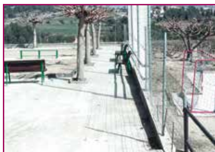
El Maset - Obres de millora de la pista de la petanca
