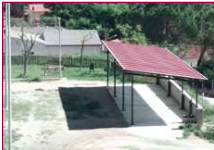
Can Parellada - Instal·lació d'una coberta a la pista poliesportiva
