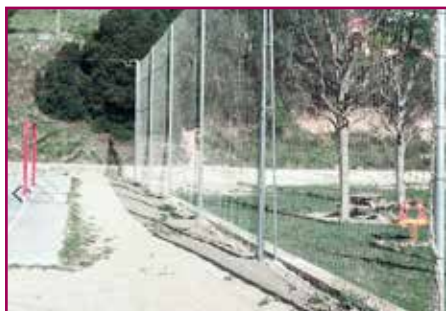
Can Parellada - Col·locació de xarxa a la pista de Can Parellada
