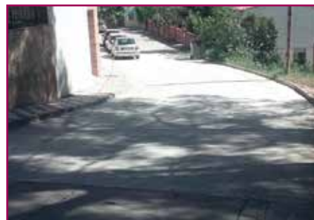
Can Parellada - Reparació del carrer Roger de Flor
