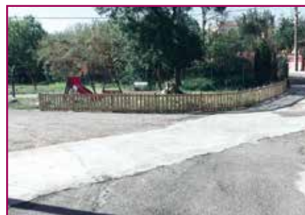
El Maset - Col·locació tanca de protecció al parc
