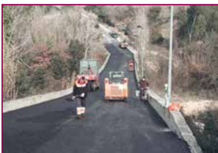
El Maset - Millora de l'asfaltat i enllumnat del pont
