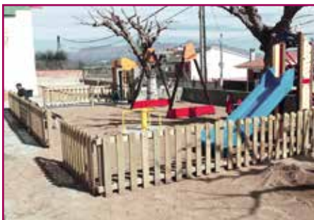
Can Quiseró - Construcció d'un parc infantil
