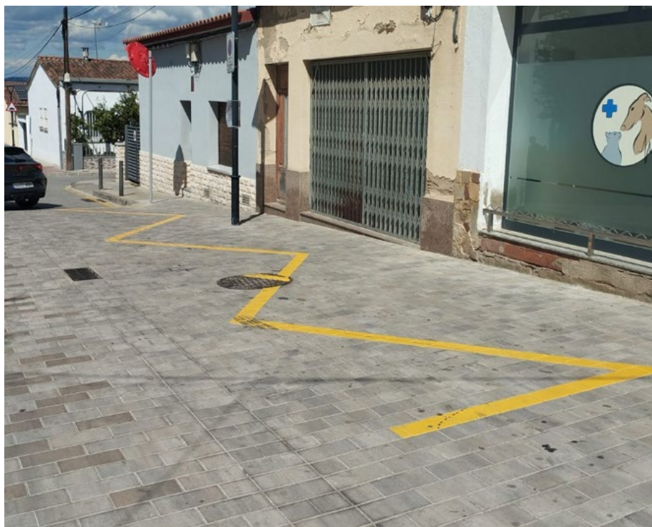
Fig. 3.93. Fotografia de la zona 1 de Càrrega i descàrrega
