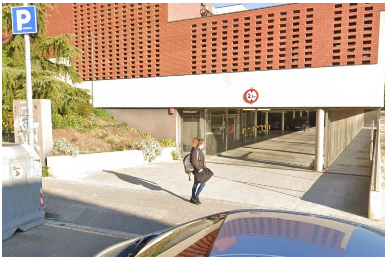
Fig. 3.77. Aparcament soterrat del CAP
