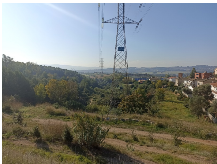
Imatge 12. Vista del torrent aigües amunt de la carretera B-224
