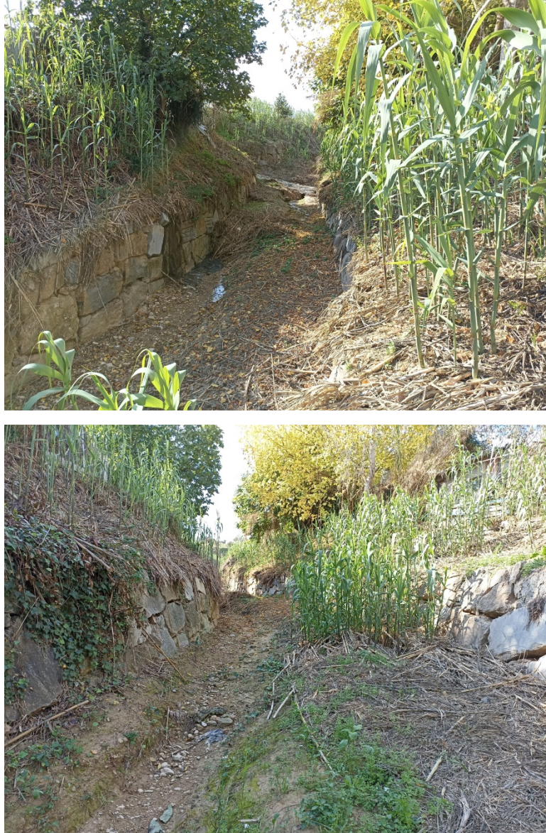
Imatge 22. Vista del torrent abans de l'obra hidràulica
