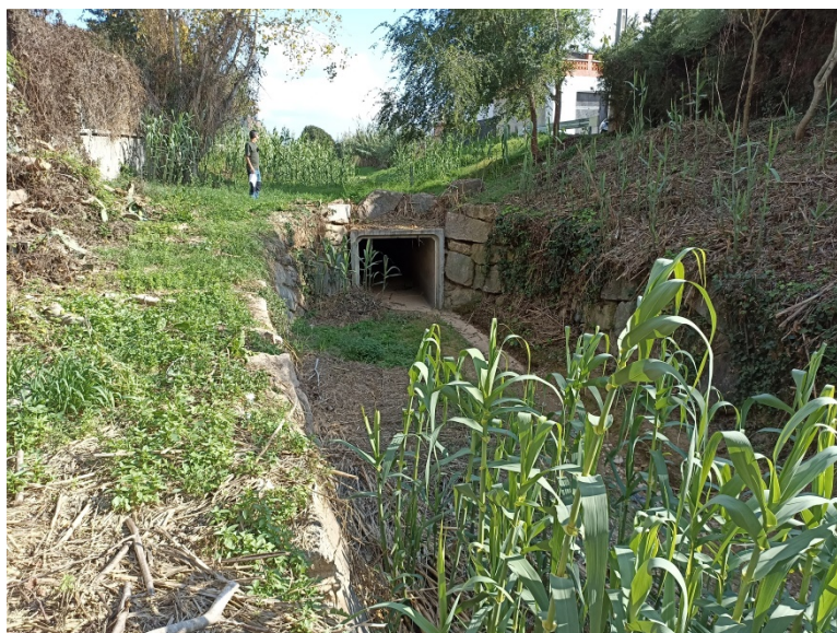
Imatge 23. Vista de l'obra hidràulica abans de la urbanització de Can Maset (calaix 2x2m)
