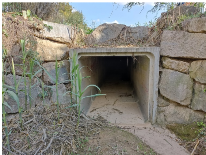
Imatge 48. Fotografies de l'estructura hidràulica del T.Font del Maset
